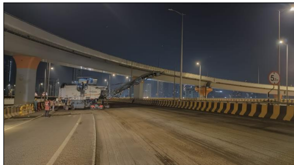
Fig 4 BC layer milling
